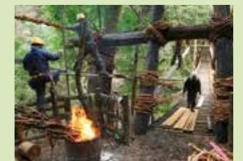
以前，每逢重建整修之際，都先將舊橋斬斷切落，現在直接進行解體施工。
